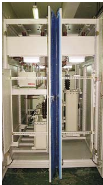
《10kV 3P 50Hz 700kvar》
