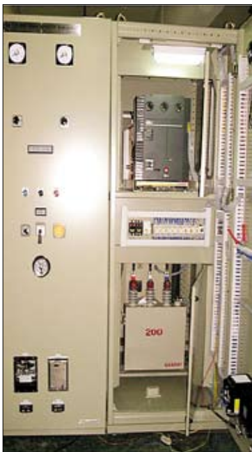
《3.3kV 3P 50Hz 300kvar》
